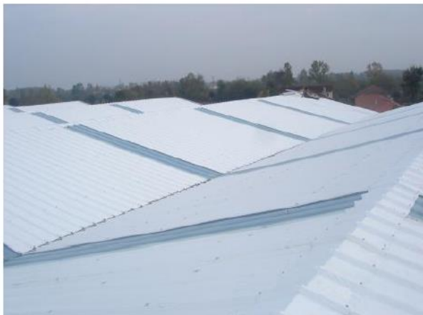
Şəkil 2.3. Dam örtüyü kimi istifadə edilən PVX trapesiya panelləri
