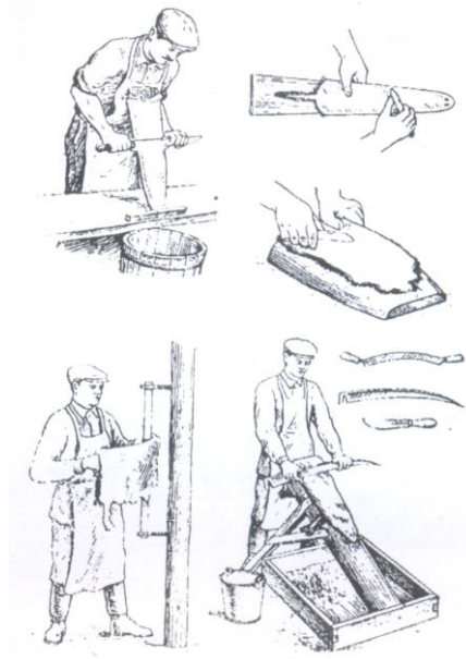
Şəkil 8. Dərilərin yağısızlaşdırılmasının müxtəlif üsulları:
