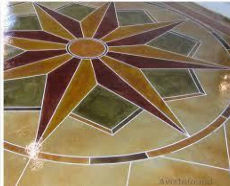
Şəkil 9. Mozaikalı beton[28]
