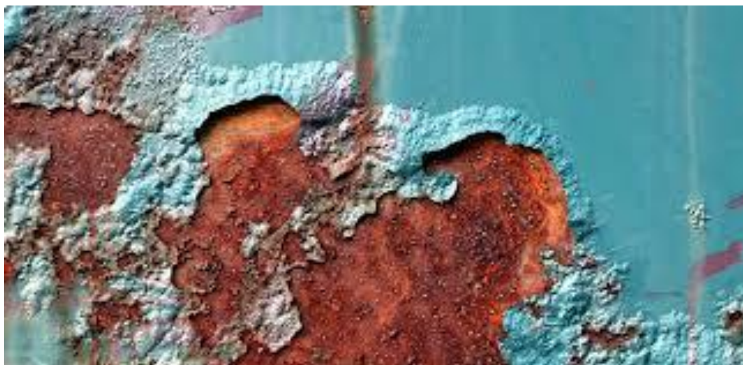
рис. 3. 9. Коррозия после нанесения защитных покрытий
