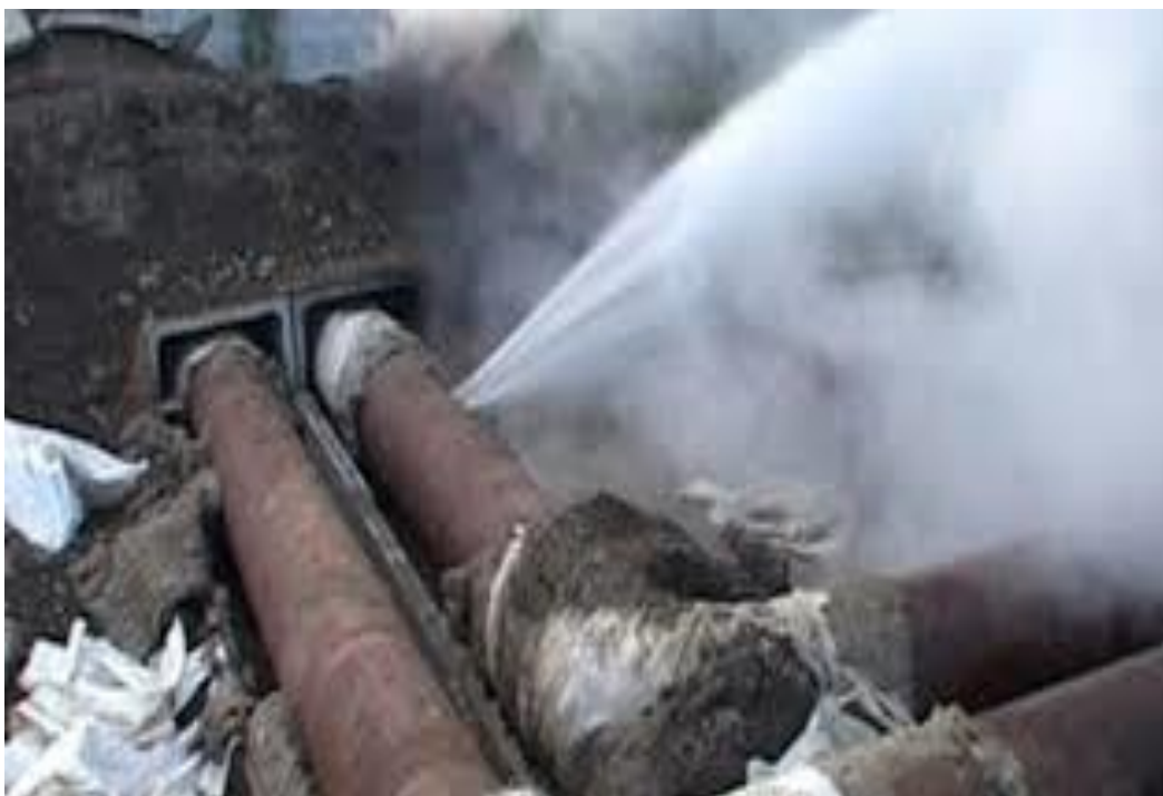
рис. 3. 12. Разрушение трубопровода
