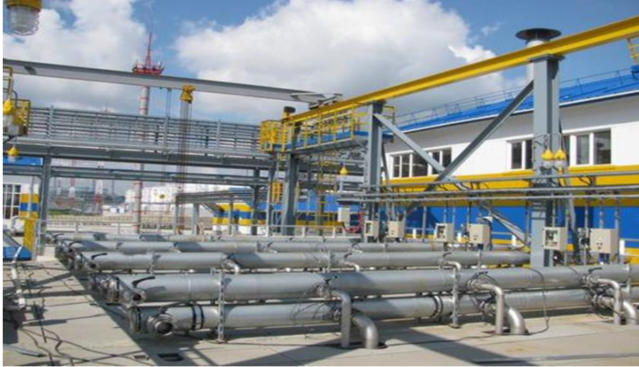
Şəkil 2.16. Təzyiqli boru kəmərləri
