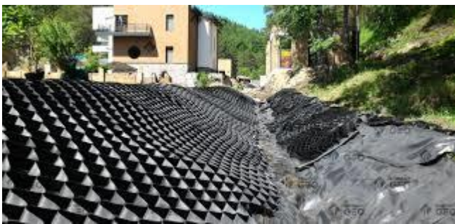
Şək.4.18. Magistral yolların geotekstille örtürülməsi
