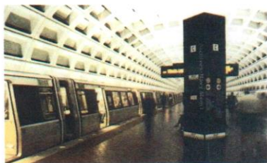
ABŞ, Vaşinqton, Qarri Uiz «Neyvi Memorial» Metro stansiyası. Ayr ı-ayrı kesson betonlarının yığma toplusu
