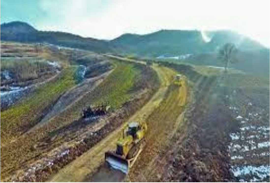
Şəkil 2: Şuşaya çəkilən “Zəfər yolu”-nün inşası
